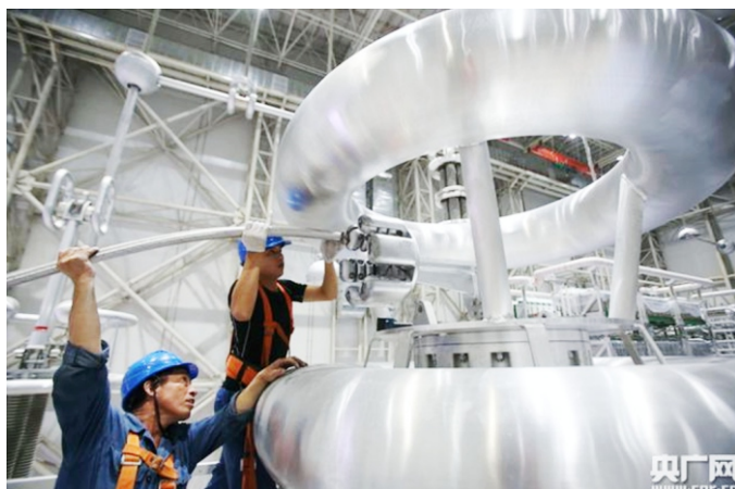
昆柳龙直流工程龙门换流站高端柔直阀安装
