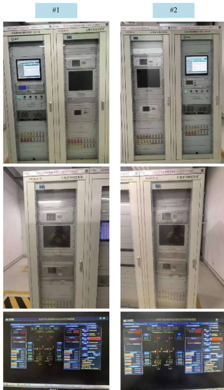
图 5 现场装置安装
