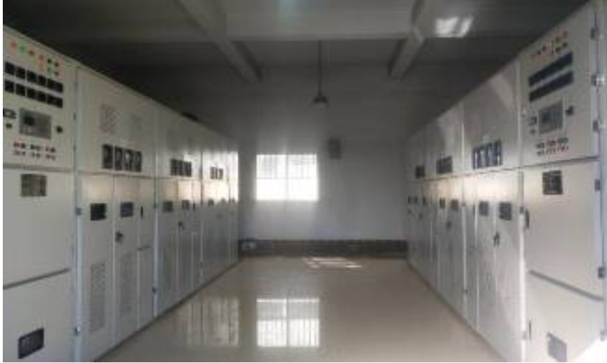
图 6 电网侧成套高可靠性并联补偿装置
