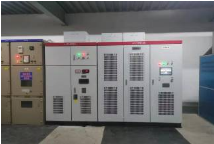
图 7 用户侧高压直挂链式有源滤波装置 APF
