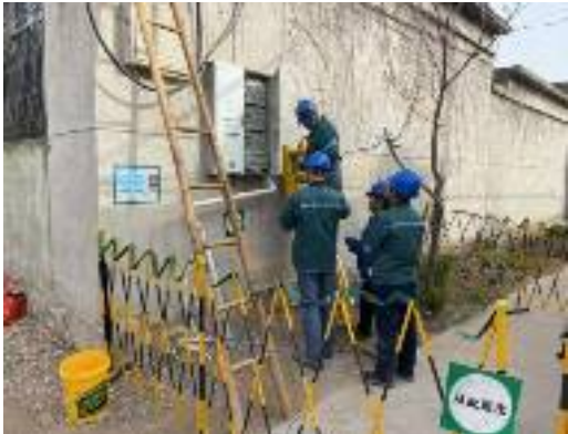
图 1-2 现场治理（压接下户线）
